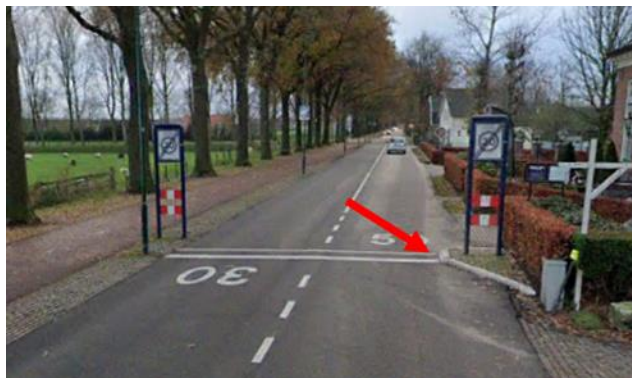
Figuur 5: Verhoging ter hoogte van overgang 30 km/h naar 50km/h
